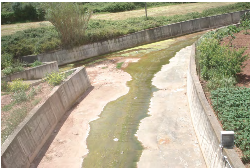
Fig.44. Canalització del torrent en zona urbana.
