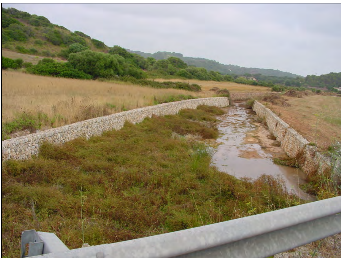
Fig. 34. Camps de conreu ocupant les ribes i riberes del torrent. Llit delimitat per paret seca.
