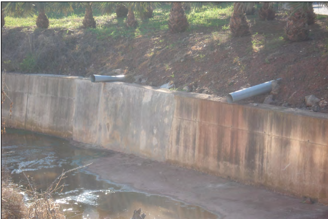
Fig. 40. Abocament de pluvials.
