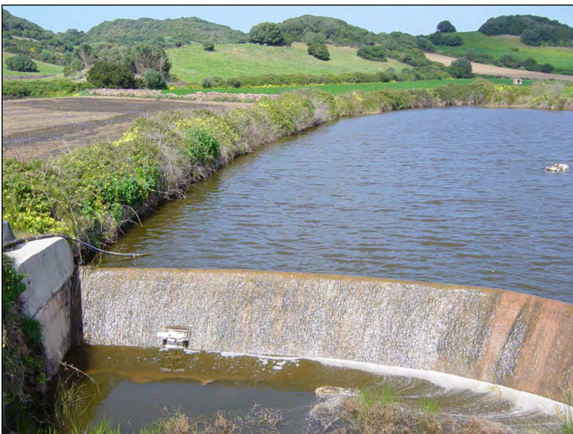
Fig. 42. Presa per a l'aprofitament agrícola de l'aigua.
