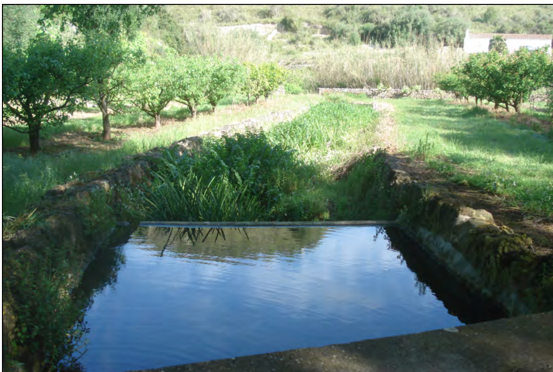
Fig. 41. Presa per a l'aprofitament agrícola de l'aigua.
