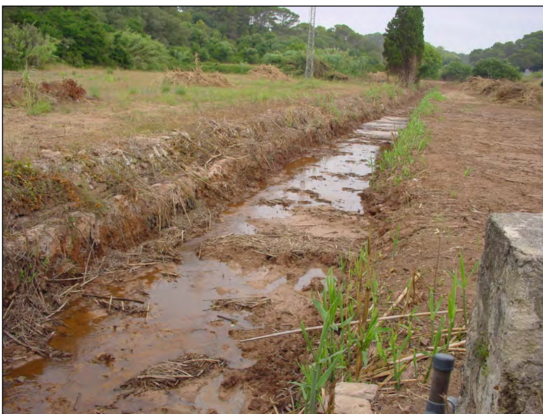
Fig.38. Neteja mecànica al torrent de Sta. Catalina. S'observa l'eliminació total de la vegetació i la compactació que ha sofert el sòl.
