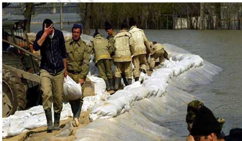
Figura 1.3.1. Disposición de sacos de arena como refuerzo para diques en Rumania, 2006.
