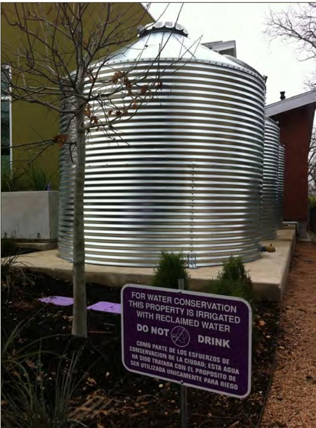
**FIGURE 4.9.2 - CISTERN USED TO MEET IRRIGATION NEEDS**
