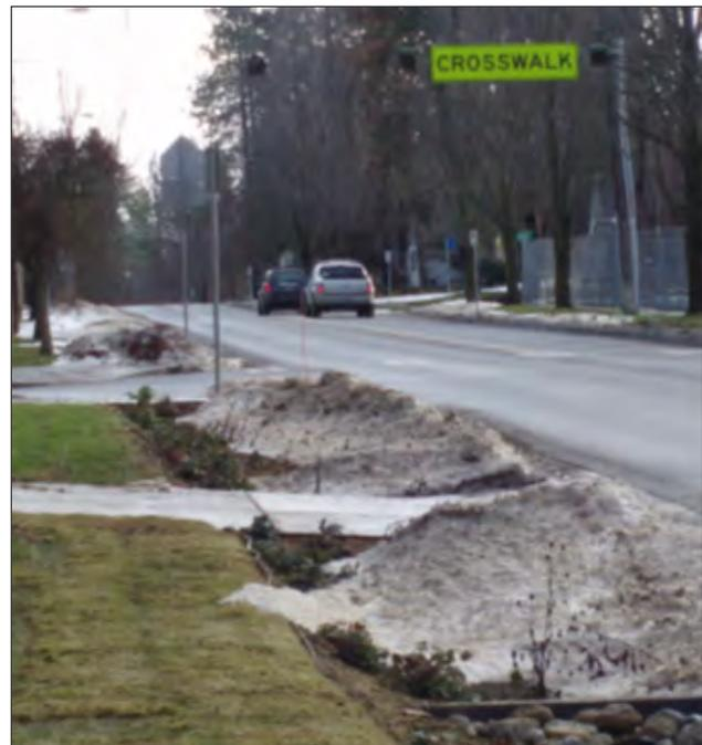
**FIGURE 3.2 BIORETENTION SNOW STORAGE**
