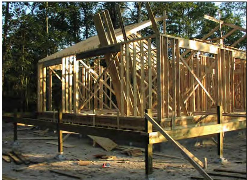
**FIGURE 4.8.7 - FLAT SITE CONSTRUCTION ON PIERS**
