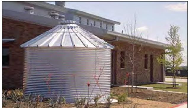
**FIGURE 3.13 RAIN WATER COLLECTION SYSTEM**
