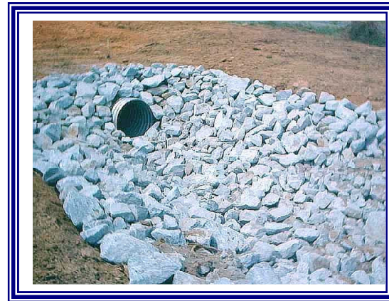
Riprap Outlet Protection
