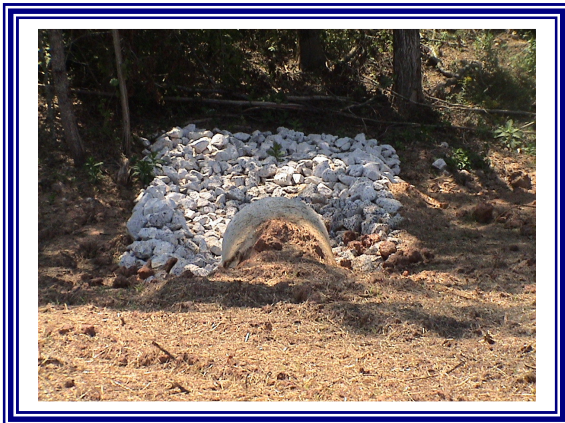
Riprap Outlet Protection
