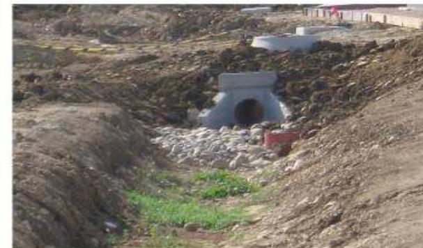
Detalle transición Zanja - Filtrante - Tanque
