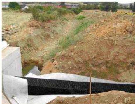
Zanja filtrante: conexión al punto de vertido (regata natural) y detalles constructivos
