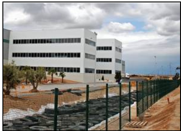
Figura 9. Depósito de Laminación-Infiltración de pluviales relleno con neumáticos usados. Zaragoza.
