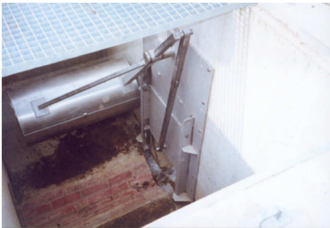
Regulador de caudal con flotador lateral.
