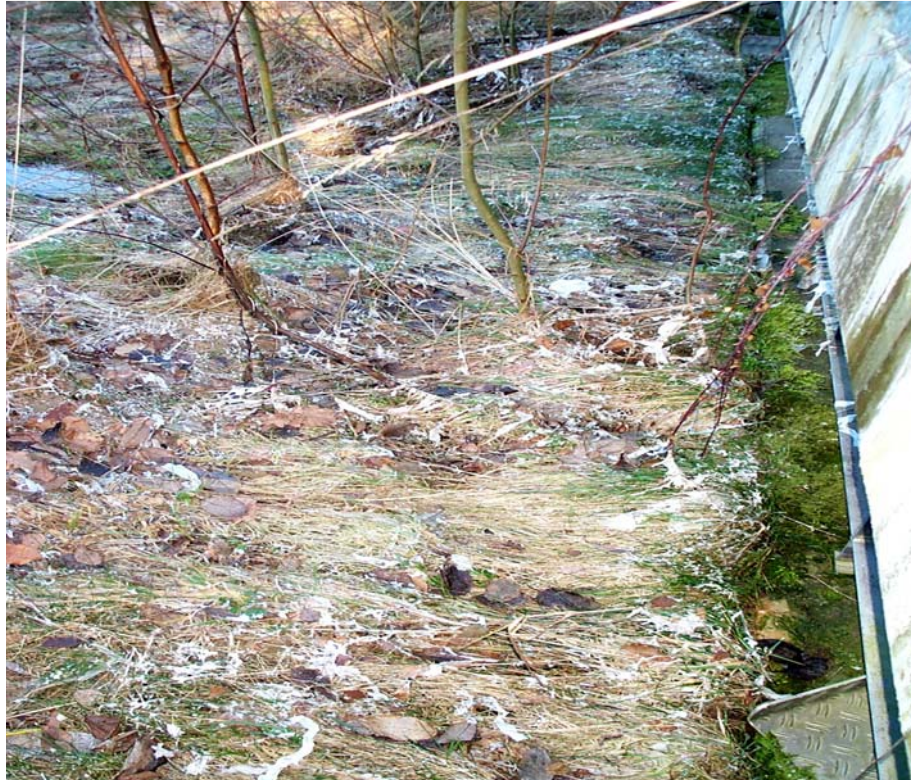
Contaminación en el curso del agua (antes de instalar el tamiz de limpieza automática tipo PAS)
