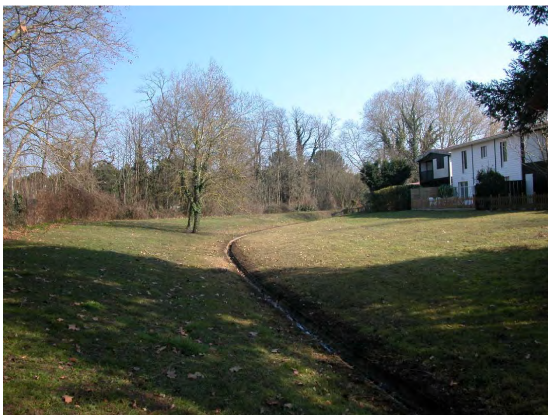
Noues Lotissement Villaboïs Rue du Lac à Bruges
