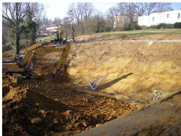
Travaux Terrassement / Remblais
