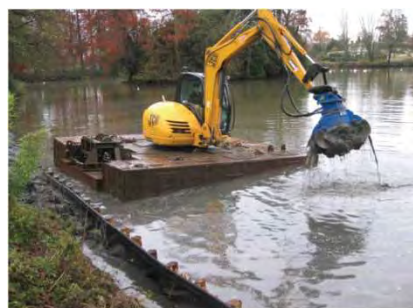
Curage du fond de bassin
