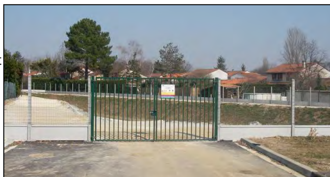
Implantation d'une clôture et d'un portail d'accès
