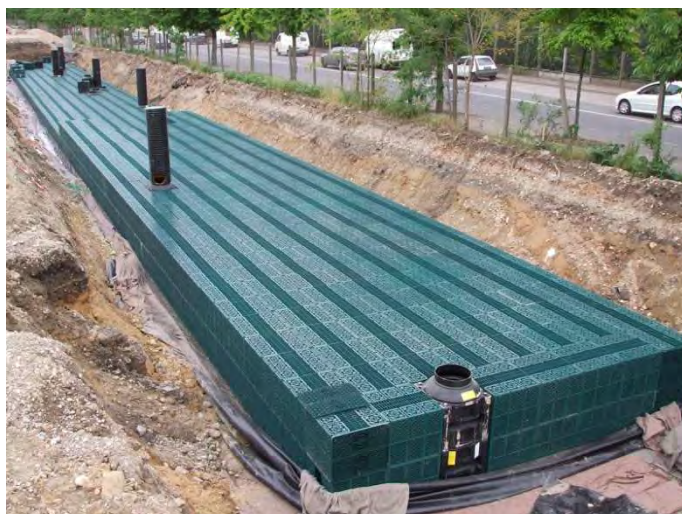
Bassin enterré à structure alvéolaire
