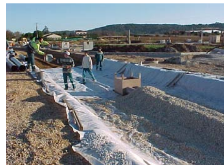
Préparation de la structure-réservoir à St Mathieu de Tréviers (34) Source DDE 34
