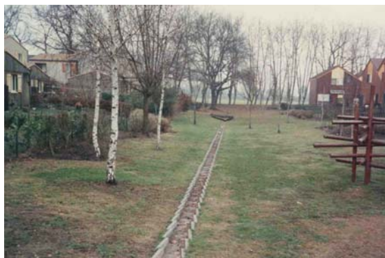
Noue et cunette en béton à Villaboïs Bruges (33) Source CETE du Sud-Ouest
