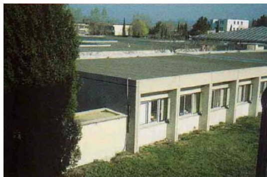
Toiture – terrasse Source CERTU
