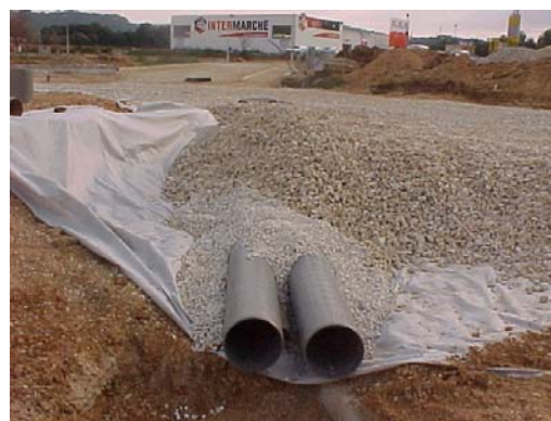
Vue de la structure de St Mathieu de Tréviers (34) avec les drains Ø 300 mm Source DDE 34
