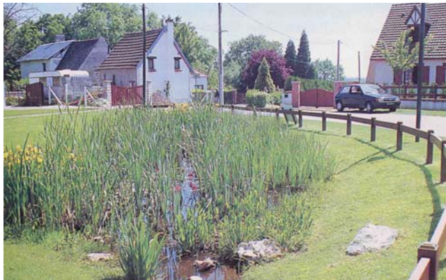
Noue engazonnée Opération Belbeuf – 76 Source Foncier Conseil
