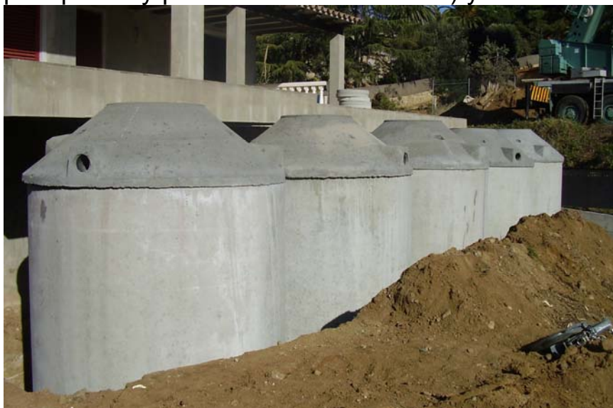
Figura 3. Colocación en obra de depósitos de hormigón (prefabricados) conectados en serie (Fuente: aiguadepluja.cat)
