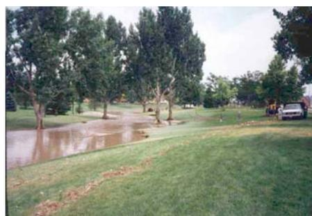
*Figura 32: Canal de drenaje urbano en un área verde, con taludes tendidos.*
