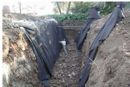
*Figura 11: Zanja de infiltración en construcción.*
