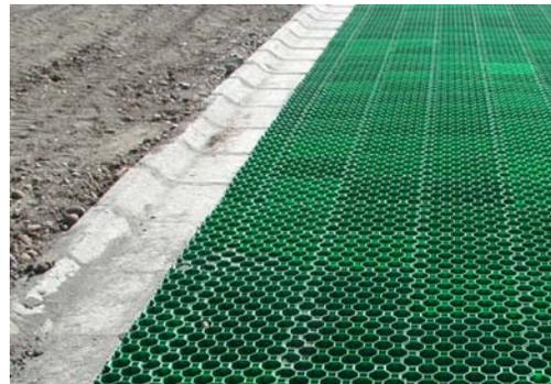
*Figura 9: Pavimentos permeables.*
