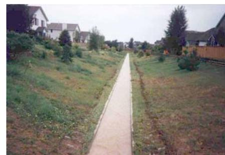
*Figura 34: Canal de drenaje de aguas lluvias con protección de erosión para flujos más habituales.*
