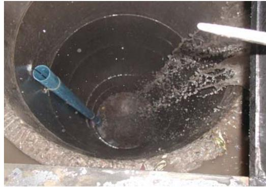
*Figura 12: Pozo de infiltración semiprofundo.*
