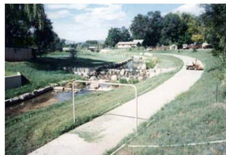
*Figura 33: Canal de drenaje urbano con protección para erosión y caída para disipación de energía.*
