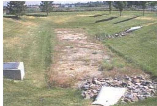
*Figura 10: Estanque de infiltración.*
