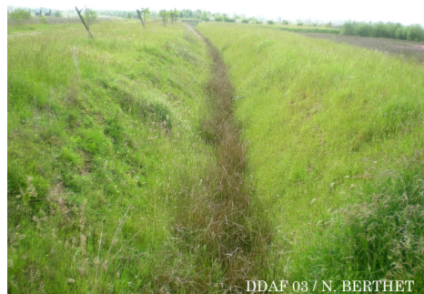
Figure 6 : Exutoire EP fossé
