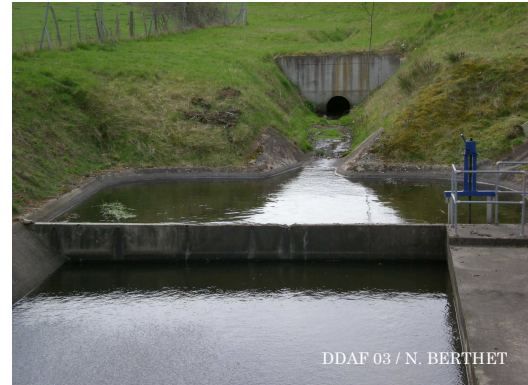
Figure 10 : Bassin de décantation
