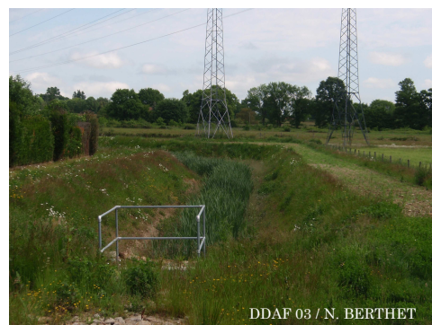
Figure 8 : Bassin sec à ciel ouvert
