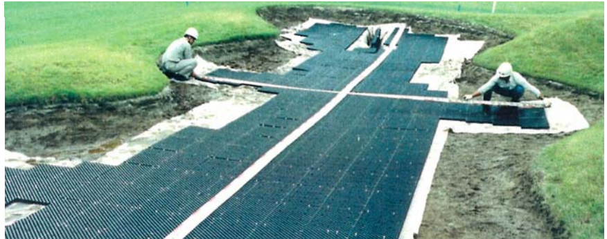
3. Las celdas se cubren con tejido geotextil.
