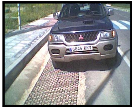
4. Gravilla estabilizada con celdas de 52 mm
