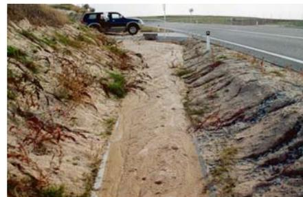
**d) Impacto visual:** La construcción de cunetas revestidas aumenta la zona de afección de la carretera, aumentando innecesariamente la superficie impermeabilizada y reduciendo la cubierta vegetal; este problema es especialmente evidente al construir las cunetas de coronación y bajantes, que además constituyen una trampa mortal para la microfauna que cae en ellas.
