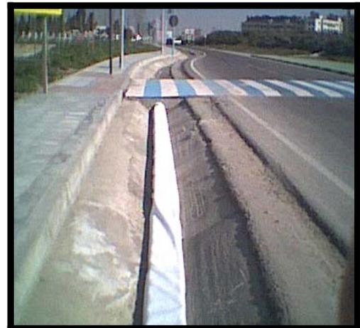
2. Envoltorio celdas con geotextil permeable
