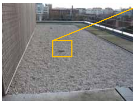
Centre Technique des Espaces Verts à Vanves (92)
