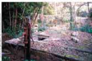
Citerne de récupération des eaux de pluie
