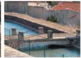
Pont sur le canal, haut du Parc Iméaire Est
