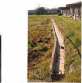
Rigole d'irrigation en état sur le site
