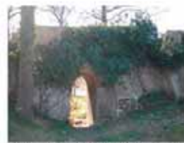
Ouvrage ancien du ruisseau du Bois Chenu
