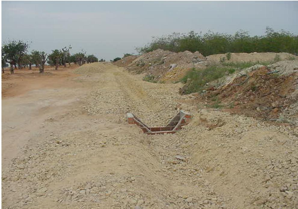
Figura 14. Zanja filtrante perimetral en la ampliación del .Polígono Industrial Sector 1.
