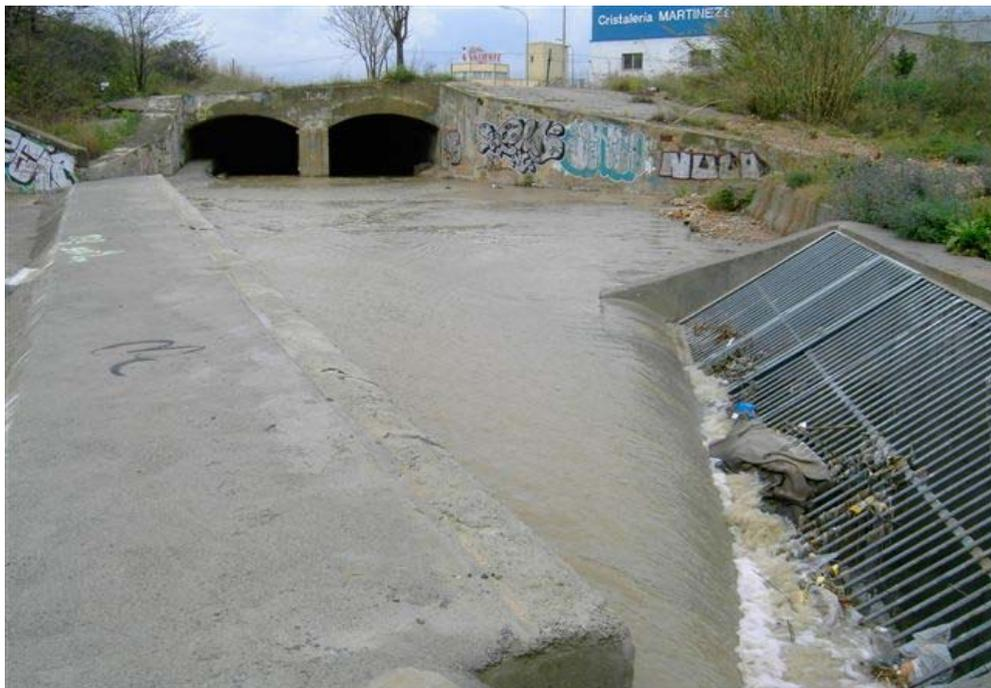
Figura 15. Final de canalización del Barranco de La Fuente. Aliviadero con reja protectora.
