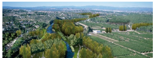
Figura 3 . Infraestructura Verde del área metropolitana de Valencia: río Túria
