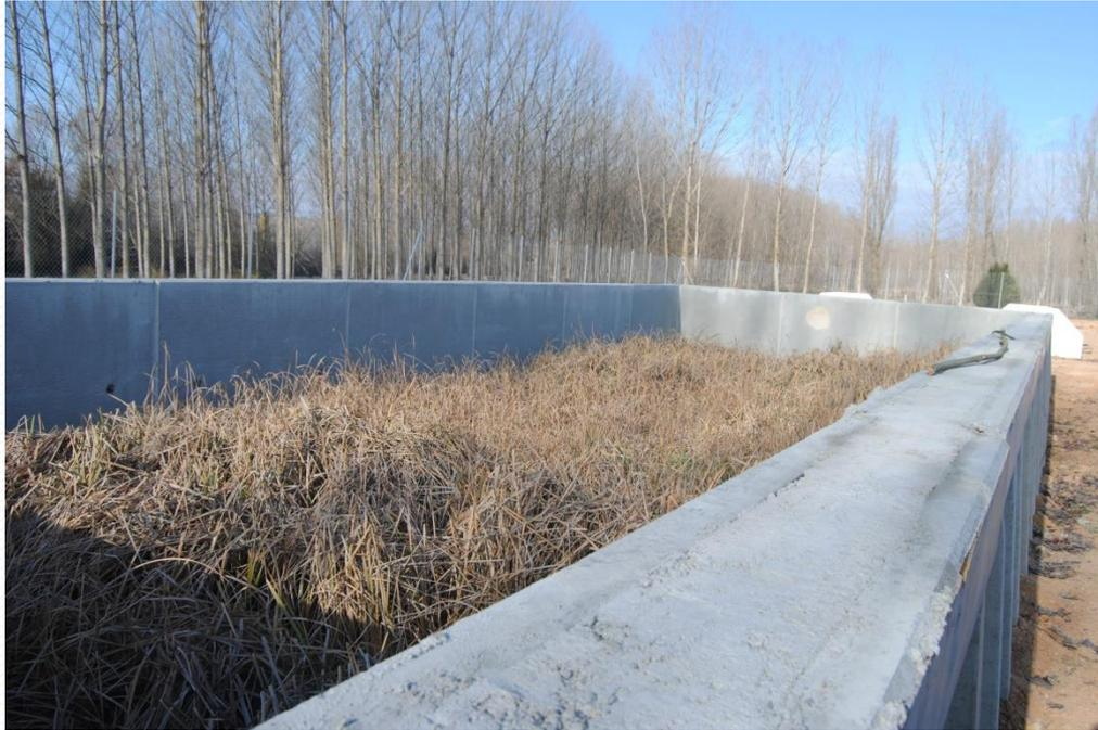
Macrofitas en flotación en tratamientos primarios (tanques Imhoff, decantadores–digestores, etc.) → Mejora rendimientos y protección contra los olores (EDAR Langa de Duero)
