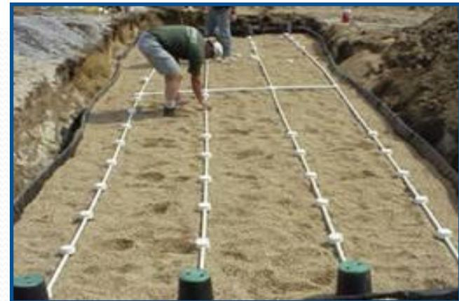
**Lechos de arena:** espesor 0,6-1,1 m / sistema superficial de distribución del agua a tratar / drenaje para la recogida de los efluentes
