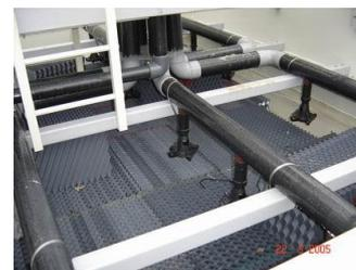
Système de répartition de l'effluent
