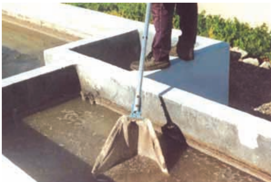
Foto 5.5. Extracción de grasas en el Desengrasador.
