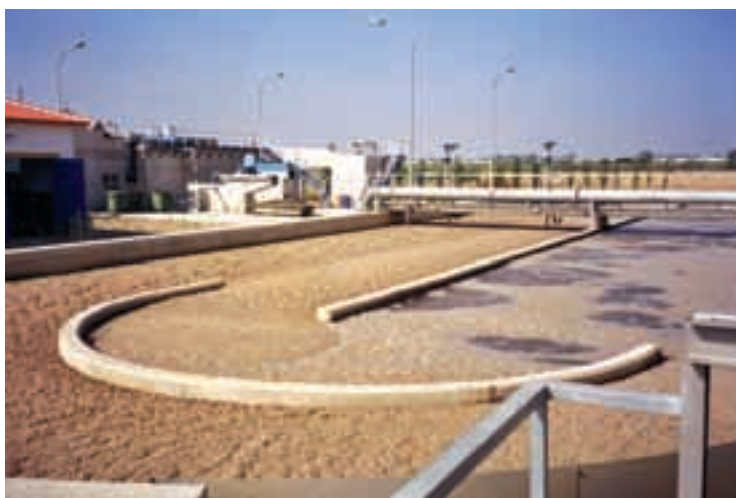
Foto 5.21. Reactor Biológico. EDAR de El Rocío (Huelva).
