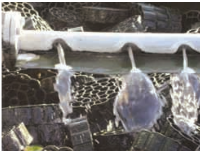
Foto 5.18. Detalle del material plástico y brazo giratorio del Lecho Bacteriano.
