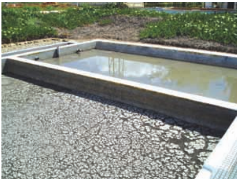
Foto 5.16. Detalle de Filtros de Turba operativos (inundados) y en regeneración (secado de costra superficial). PECC.
