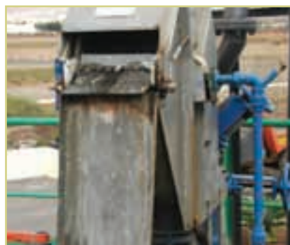
Foto 3.5. Tamiz rotativo. EDAR AENA Arrecife (Lanzarote-Las Palmas)
