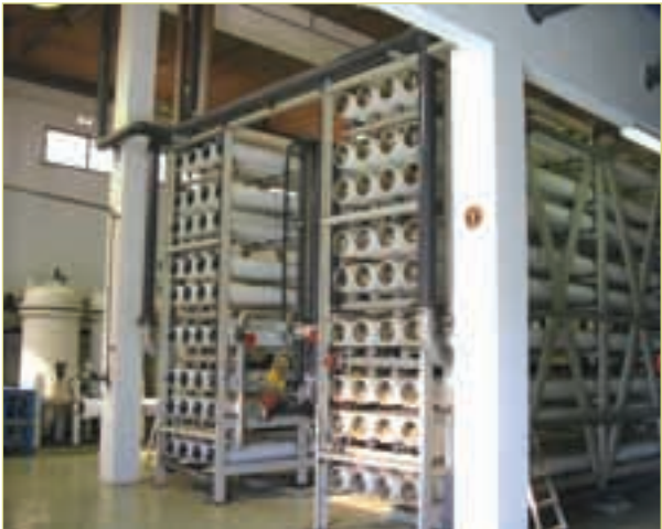
Foto 3.12. Detalle de tratamiento terciario. EDAR del Sureste de Gran Canaria (Las Palmas)
