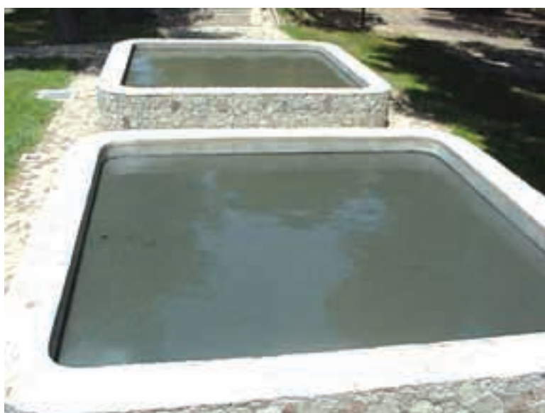
Foto 5.13. Lagunas Anaerobias. Centro de Transferencia Tecnológica (Tetuán).
