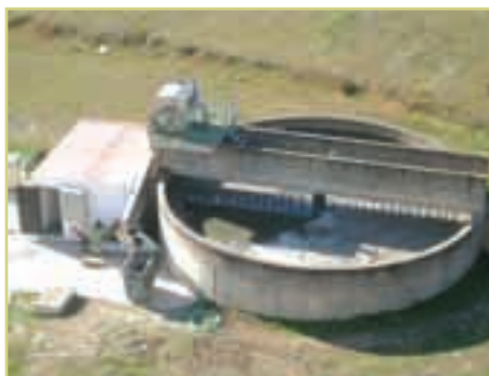
Foto 3.13. Espesador de lodos. EDAR de Manilva (Málaga)
