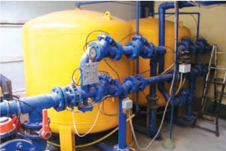
Foto 5.25. Filtros de Arena. EDAR AENA Arrecife (Lanzarote - Las Palmas).
