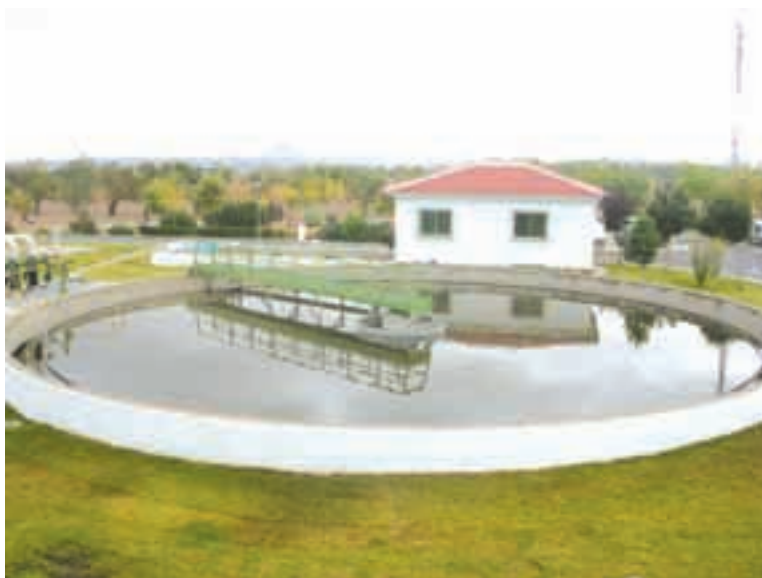
Foto 5.8. Decantador Primario. EDAR de Baza (Granada).
