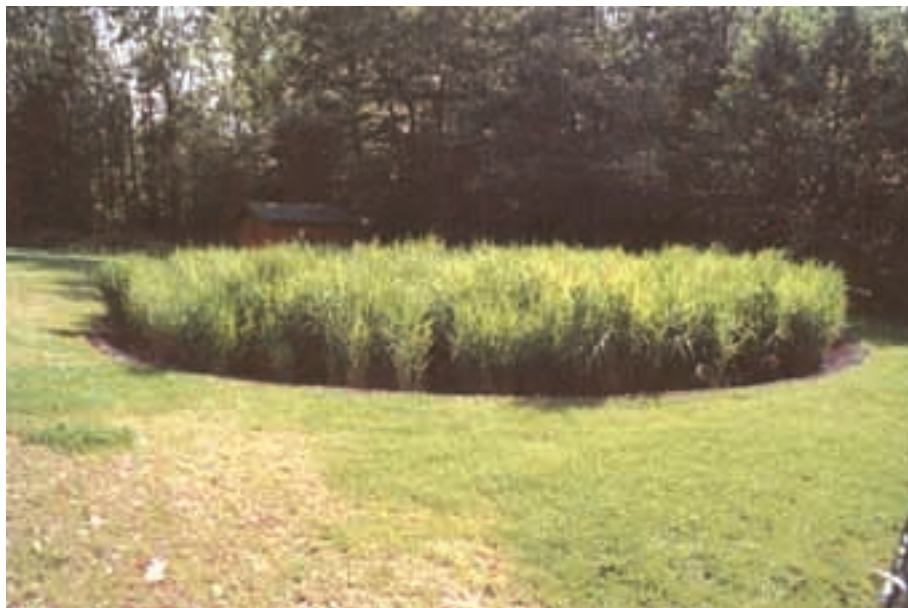
Foto 5.10. Humedal Artificial de Flujo Subsuperficial Vertical. PECC.
