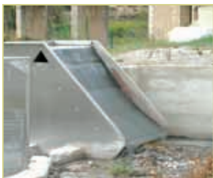
Foto 3.4. Tamiz estático. EDAR de Fondón (Almería)
