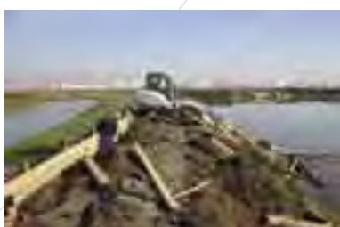
Colocación de tables- tacado y reparación de vuelta de fuera en "La Covacha"
