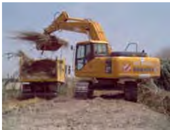
Retirada de la vegetación del canal primetal de la Laguna de Fuente de Piedra
