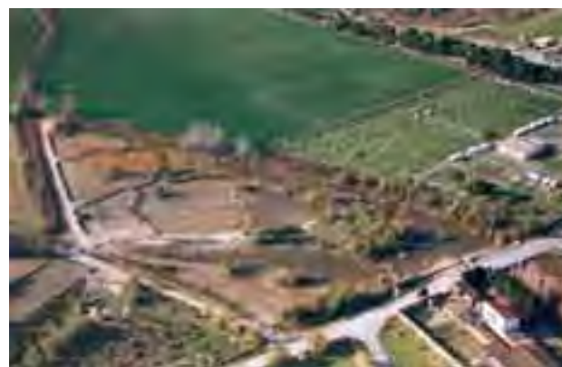
Humedales de depuración
