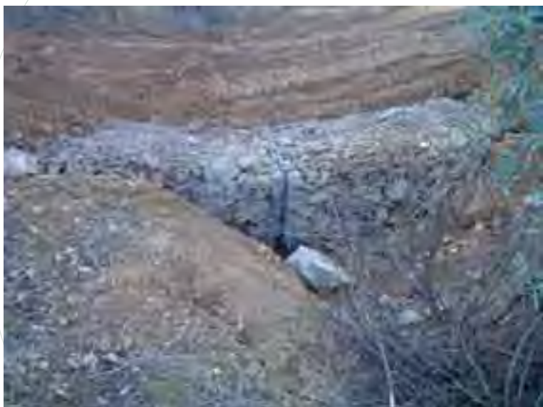
Dique de mampostería gavionada para la corrección de cárcava en Laguna Amarga
