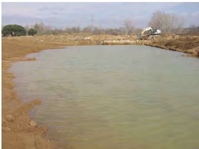
Obras para la creación del humedal artificial de Tordena. Proyecto LIFE “Acuífero Tordena”
