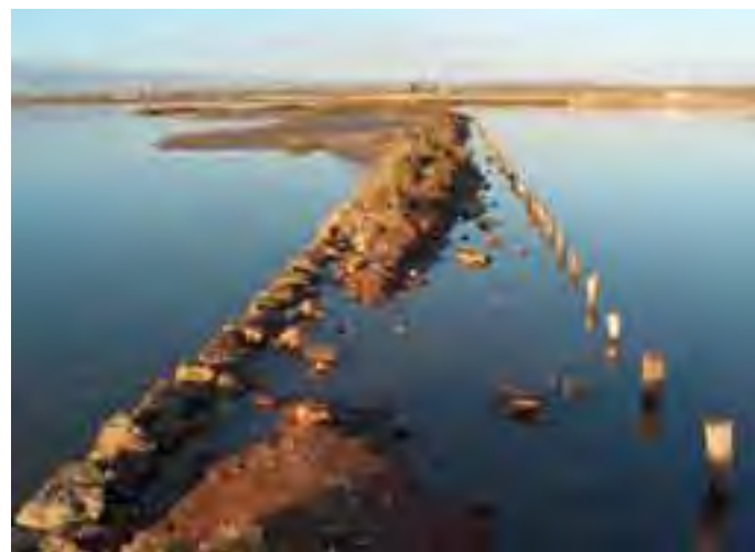
Rehabilitación de antiguo dique
