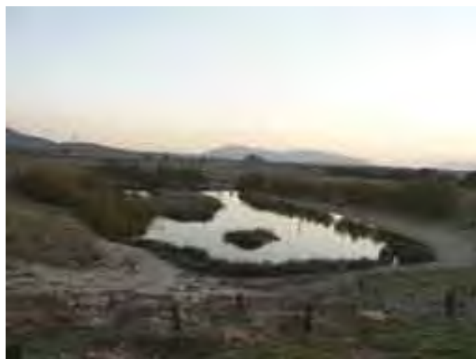
Humedal artificial acondicionado en antigua cantera para la extracción de áridos
