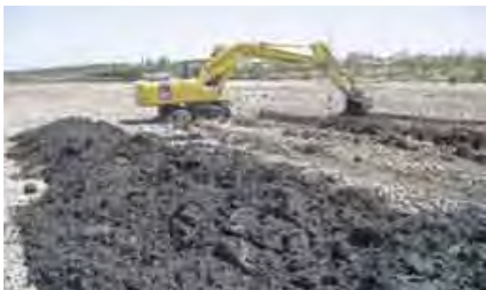
Retirada de lodos del Laguneto
