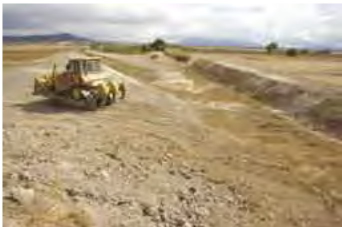
Acondicionamiento de la desembocadura del Arroyo Santillán en la Laguna de Fuente de Piedra
