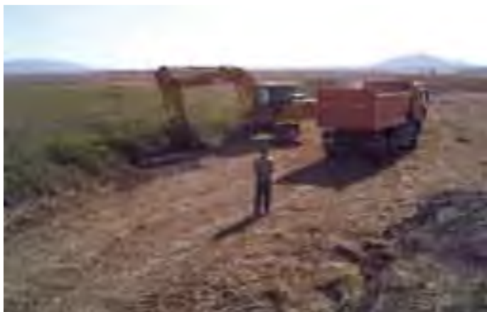
Clausura del canal de drenaje de la laguna de Cantarranas
