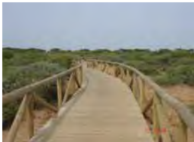
Pasarela de acceso. Proyecto LIFE “Conservación de hábitats litorales en la provincia de Cádiz”
