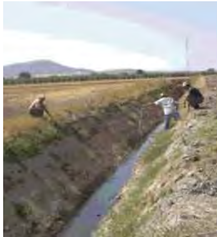
Comprobación de la cota del canal de desagüe del Laguneto en Fuente de Piedra
