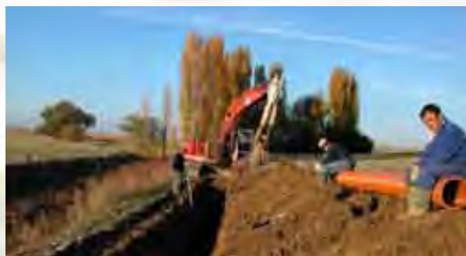
Construcción de by-pass para evitar la entrada de aguas residuales en la laguna de Boada. Actuación realizada a posteriori del Life Medio Ambiente y financiada en su totalidad por la Confederación Hidrográfica del Duero.
