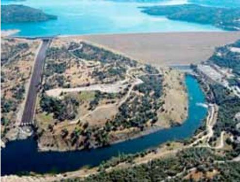
Figura 15. El embalse Oroville del Estado de California abastece de agua a regantes, opera para controlar subidas de caudal y entrega agua a la central hidroeléctrica Edward Hyatt, que funciona acoplada con la central Thermalito. Thermalito puede bombear agua de regreso al embalse para ser reutilizada por la central Hyatt.
