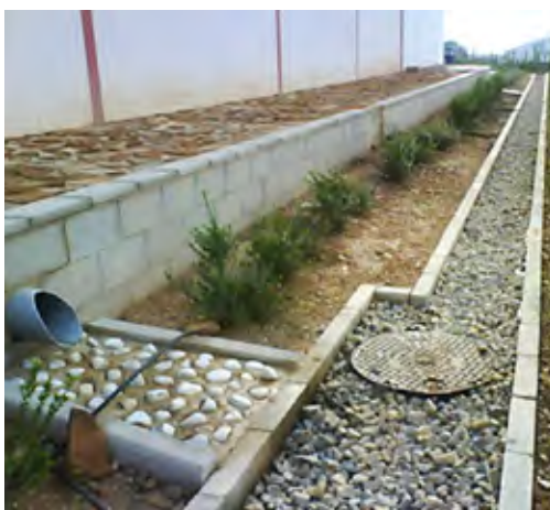
Zanja drenante en Crevillent (España).
