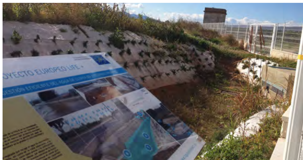
Cuenca de retención-infiltración en La Ciudad del Deporte de Xàtiva.
