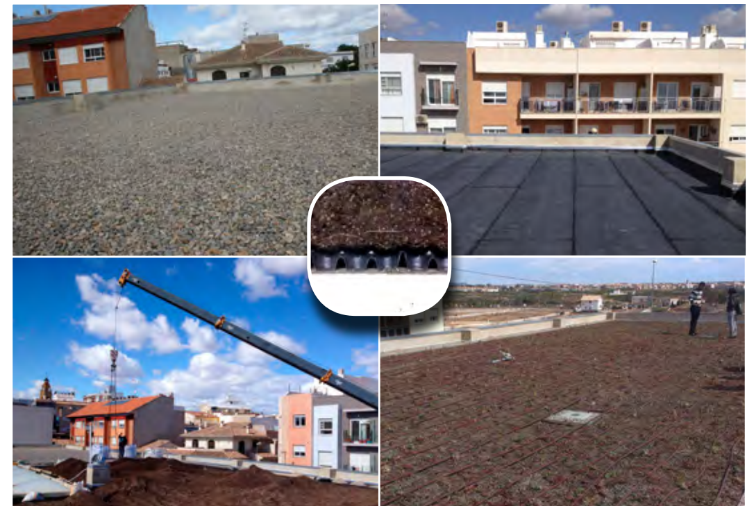
Construcción de la cubierta vegetada.
