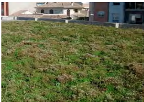
Cubierta vegetada en Benaguasil (Valencia).
