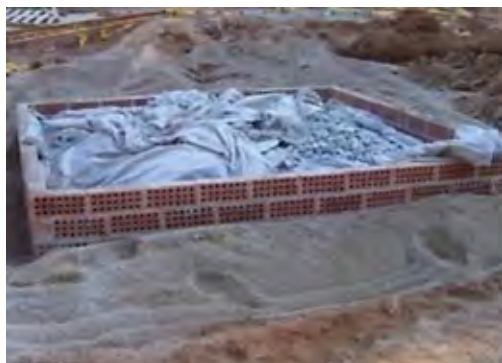
Construcción de un pozo de infiltración en Barcelona (España).
