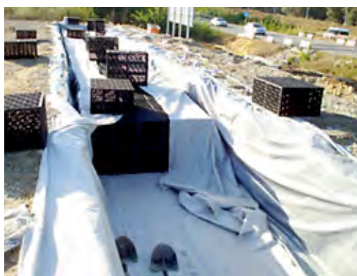
Construcción de sistema geocelular en Oleiros (España).
