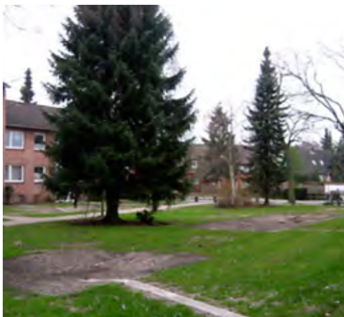
Zanja de infiltración en Hamburgo (Alemania).
