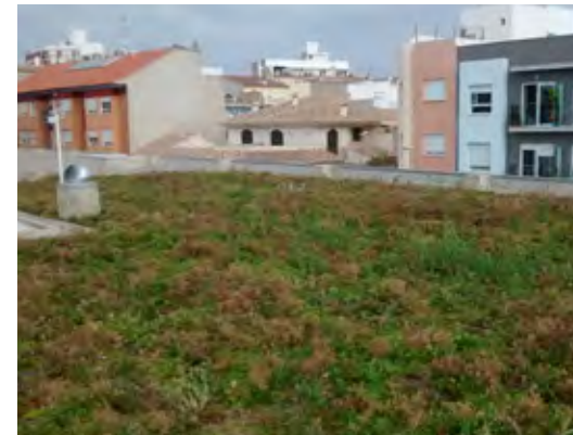
Cubierta vegetada con la vegetación completamente arraigada en septiembre de 2014.
