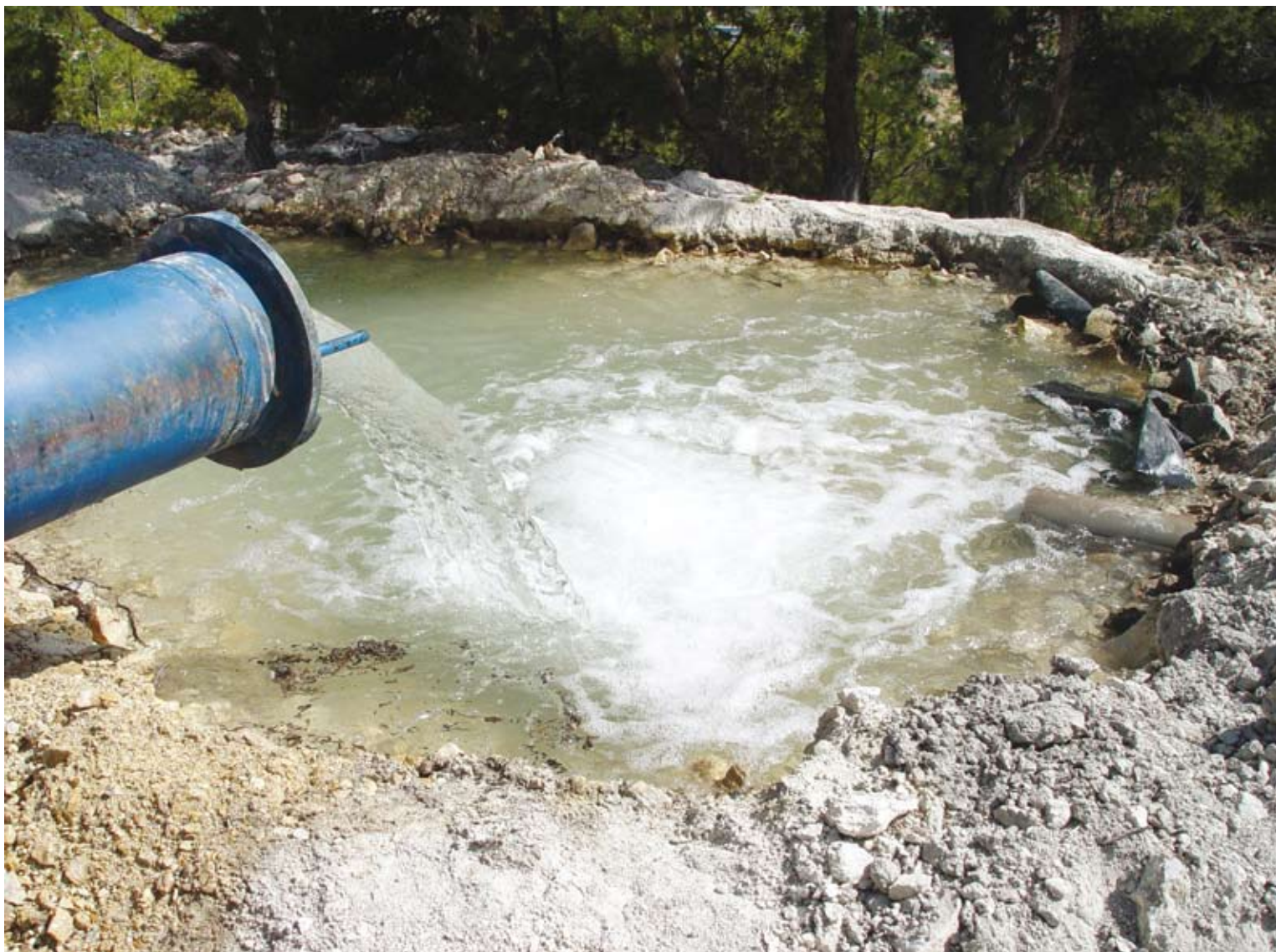
Ensayo de bombeo en Calderete (Alicante)
