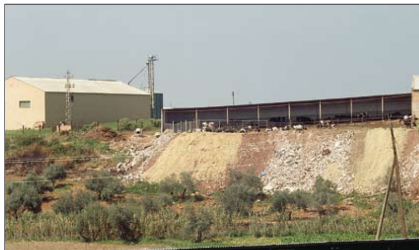
La actividad ganadera y los lixiviados que se originan pueden contaminar las aguas subterráneas si las instalaciones no se sitúan en zonas hidrogeológicamente adecuadas
