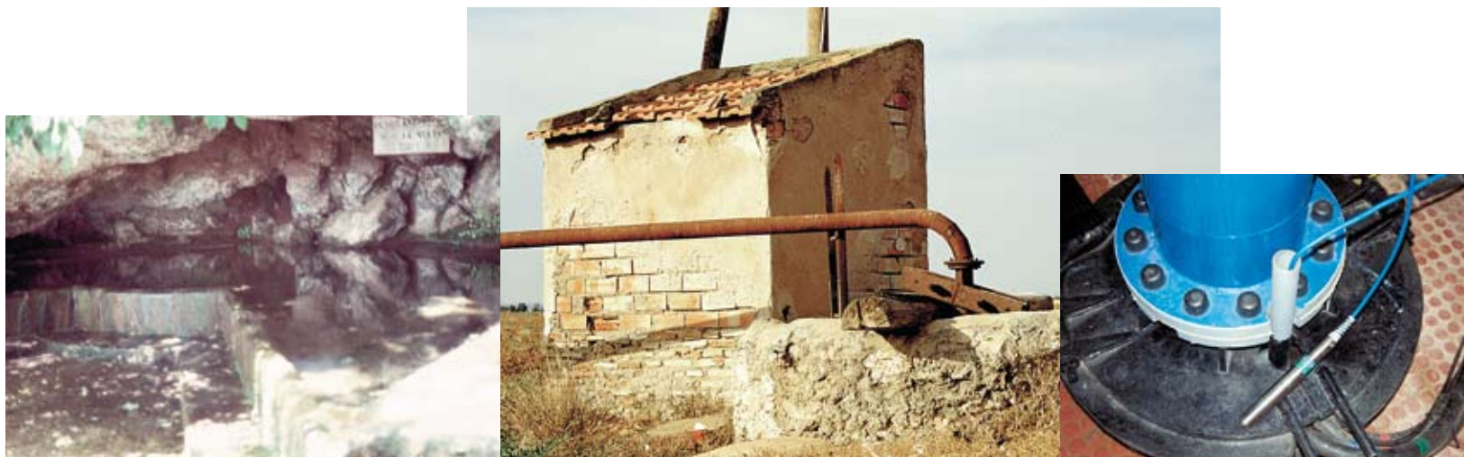
Captaciones subterráneas más frecuentes: a la izquierda, surgencias naturales (manantiales); en el centro, pozo de gran diámetro; y a la derecha, sondeo instalado de explotación (en éste se observa el dispositivo para el control del nivel piezométrico y la sonda de control)
