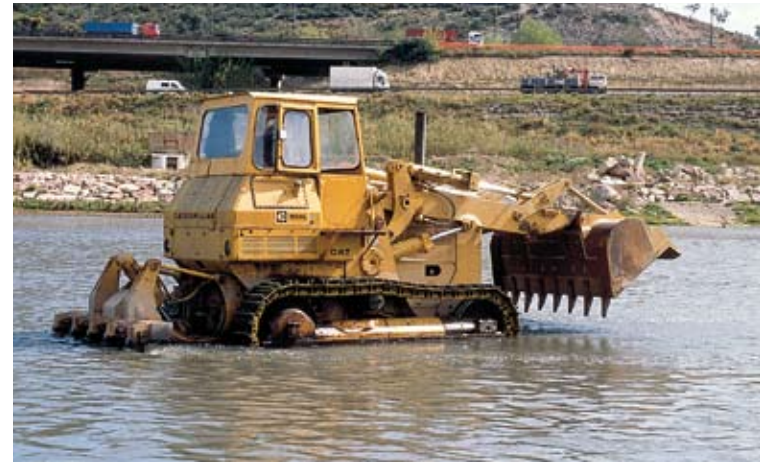
Operación de escarificado en el lecho del río Llobregat (Barcelona) para favorecer que el agua circulante por el cauce recargue al acuífero
